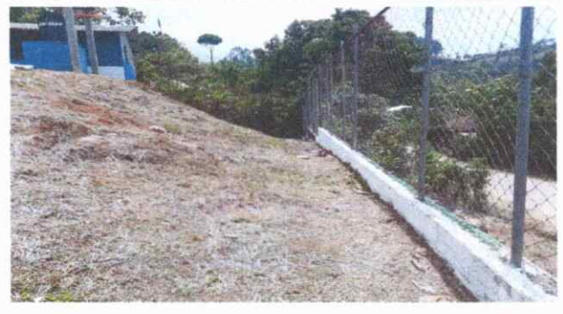
Foto 2: El espacio donde juega los niños es muy reducido y se llenara con tierra sosteniedo el muro, es espacio se ampliara.
