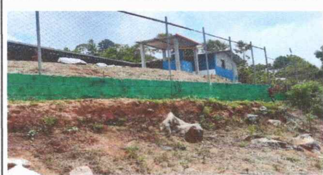
Foto 1: Se levantará un muro de 2 y media metro de altura para nivelar el corredor del establecimiento.
